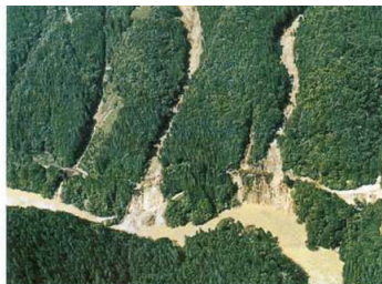
豪雨による深いつめ跡(国道418号・上矢作町達原)
