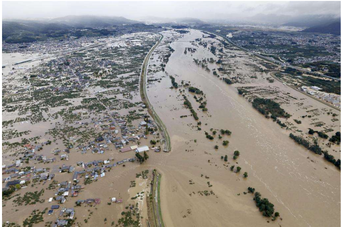
千曲川穂保地区左岸破堤(長野市)
